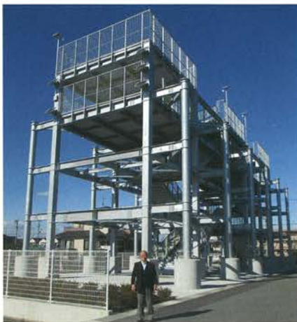
市が設置した津波避難タワー。1,000人が避難可能。港第23自治会内には7か所の津波避難施設がある。
